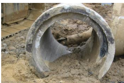
De gamle rør
