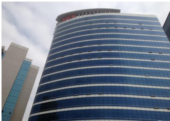
Skyskraber set fra vores tagterrasse på 5. sal. På bygningen til venstre ser man 2 vinduespudsere der hænger i 2 livliner.
