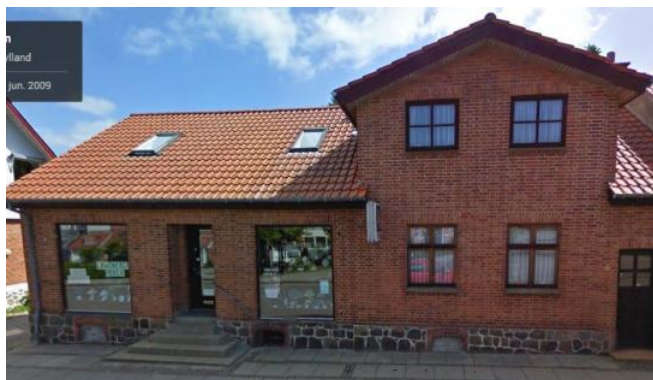
Hovedgaden 6 – før ombygning
