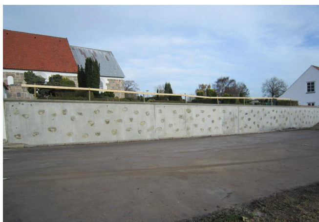
En mur bliver til.
