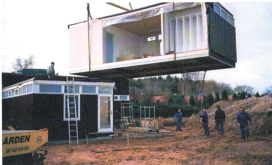
Langagerskolens bygninger under opførelse.
